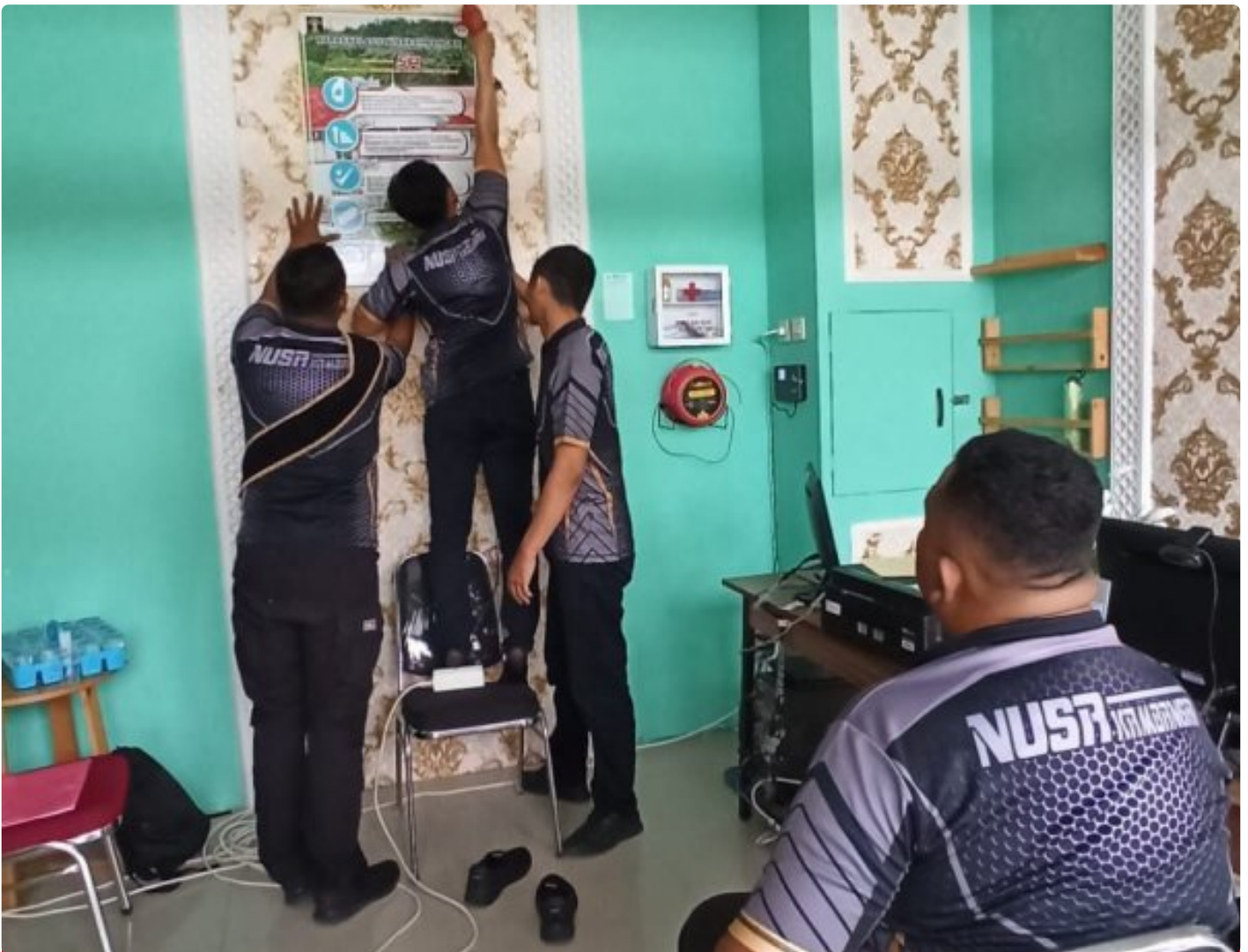
Kabapas dan Staff Renovasi Ruang Baladewa
